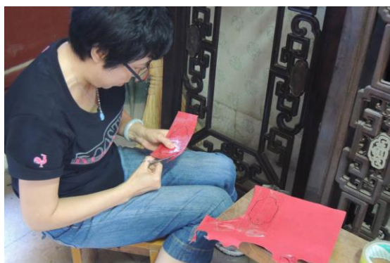
圖 1-15 內檐裝修構件嵌過缺失補配，鑲嵌修復師傅先以透明膠帶黏貼在缺損部位，再以油性筆描繪嵌洞形狀後，取下透明膠帶將其黏貼在稍厚的紙上，以剪刀剪下紙樣，再將紙樣置入嵌洞中，來回比對修正紙樣外型，直至紙樣完全與嵌洞吻合。筆者攝
