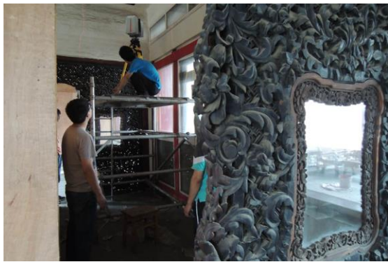
圖 2-7 長春宮建築修復現場進行 3D 測繪工作，建立所有建築結構之數據庫。筆者攝
