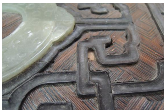
圖 1-14 內檐裝修構件採用竹絲鑲嵌手法製作，出自江南工匠之手。筆者攝
