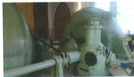
2006 年新建的水平式渦輪機軸承
