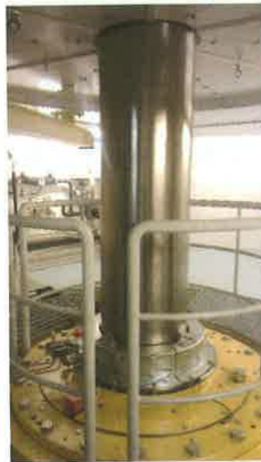
2006 年新建的水平式渦輪機軸承
