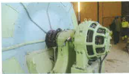
2006 年新建的水平式渦輪機軸承
