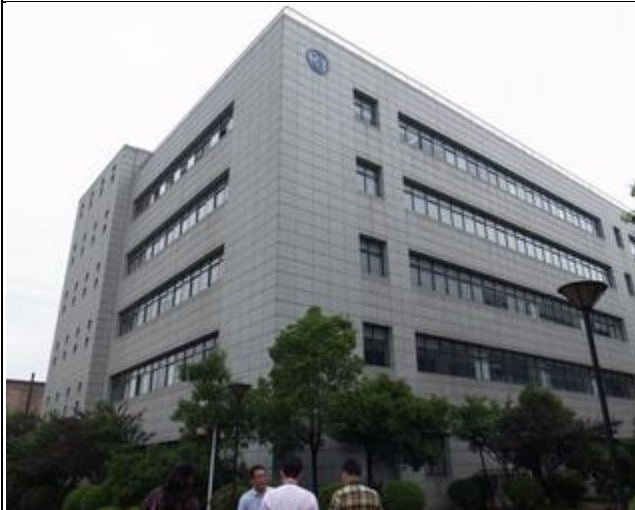
實訓基地訓練工場大樓外觀
