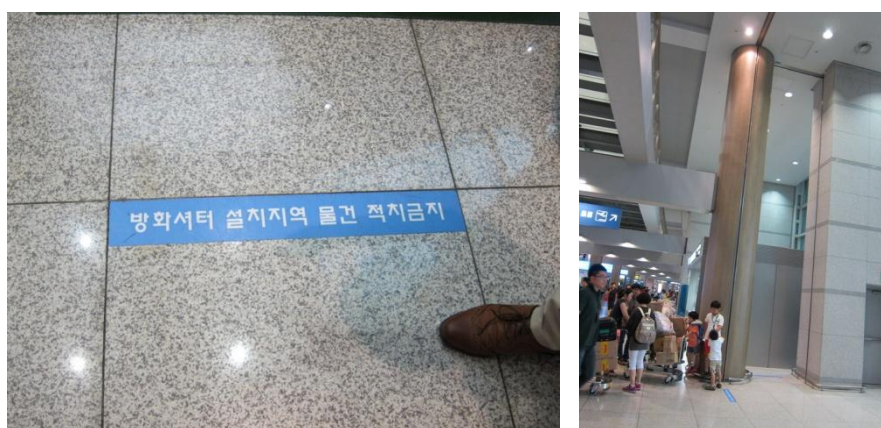
圖 24 地板上標示有「防火捲門安裝區域請勿堆置物品」的地貼
