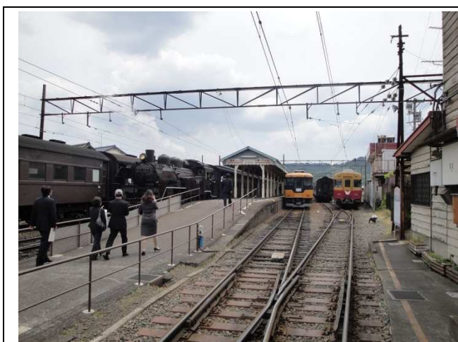
照片 6.1 大井川鐵道新金谷站月台
