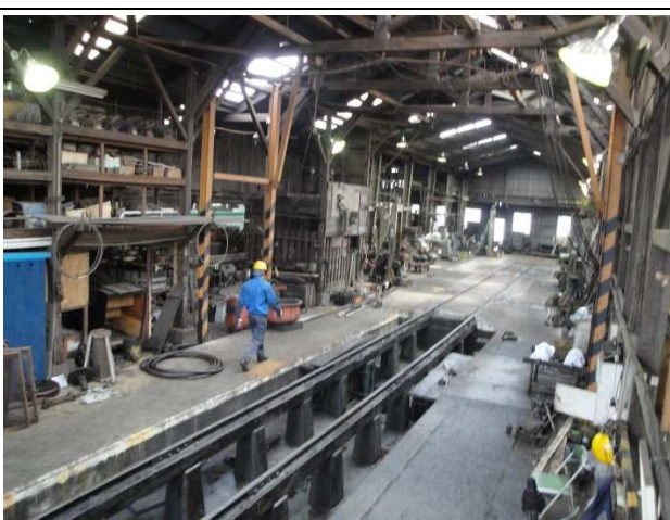
照片 6.19 修理工廠內部情形(2)
