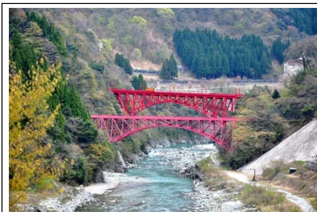
照片 4.14 新山彥橋風景
