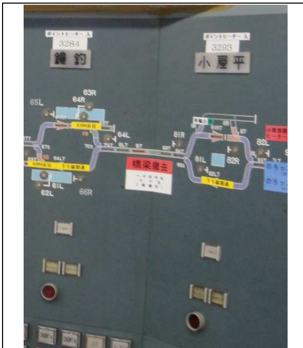
照片 4.30 顯示鐘釣至小屋平之橋梁撤去
