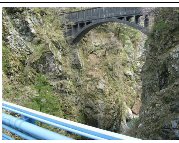
照片 4.17 行經後曳橋俯瞰峽谷窗景
