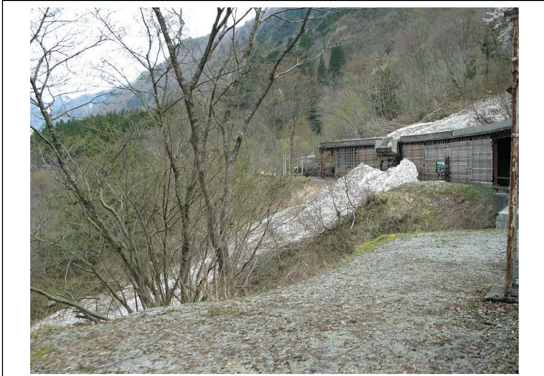
照片 4.19 黑部峽谷鐵道治理工程
