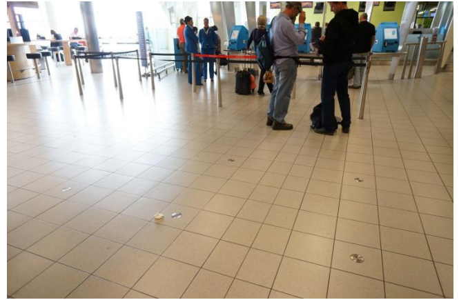
圖26：轉機櫃檯圍欄（採地面洗孔方式設置）
