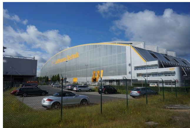
圖10：舊維修棚廠（3機棚廠）
