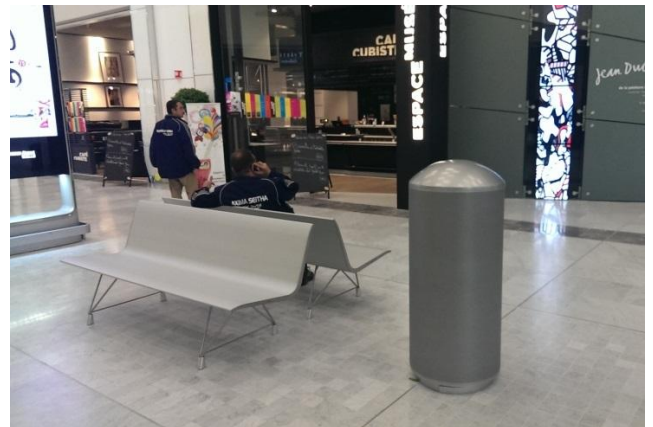
圖22：下吹式空調出風口（圖中圓柱），因冷空氣下沉特性，可減少冷源耗損。
