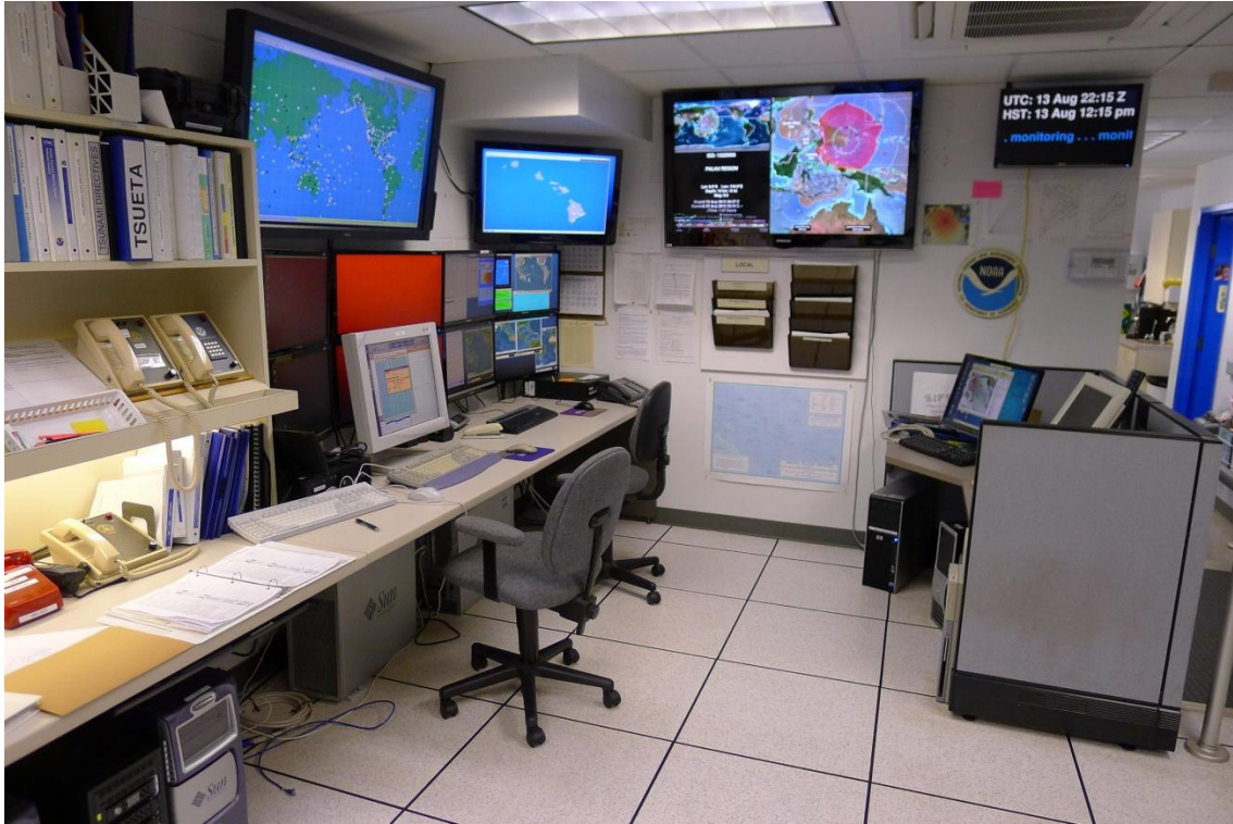
PTWC 海嘯處理、發布作業室(入門右側)
