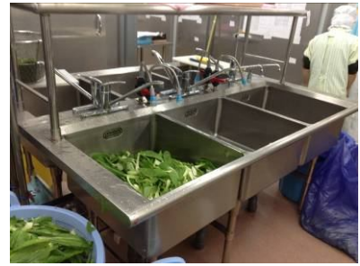
每個清洗水槽設置消毒水供應系統，方便清洗食材及器具
