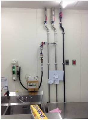
每個清洗水槽設置消毒水供應系統，方便清洗食材及器具
