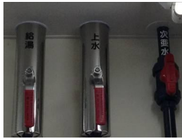
每個清洗水槽設置消毒水供應系統，方便清洗食材及器具
