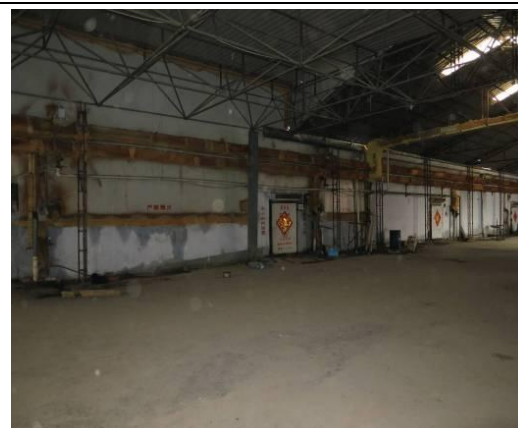
圖 8-6 茂森公司大型冷藏庫
