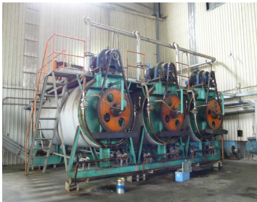
化製場之化製設備
