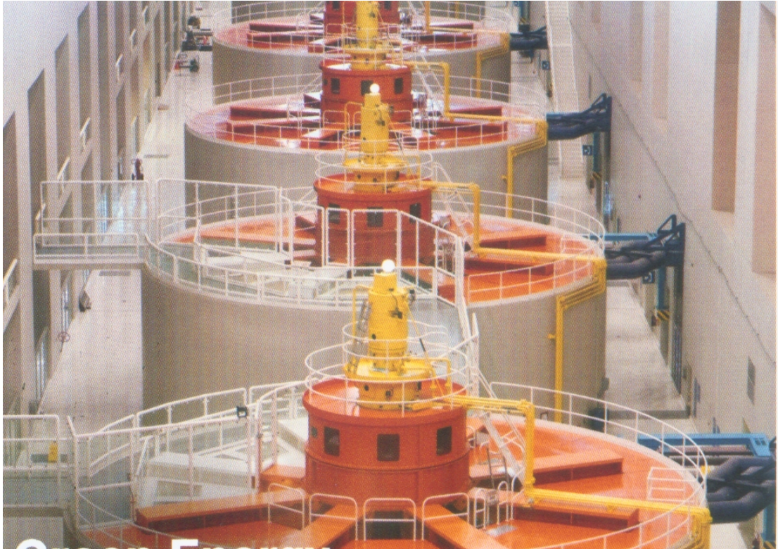
圖十五 綠能產業設備之防腐塗層
