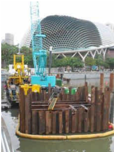
水域施工範圍，預先設置截油繩
