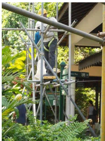
植物園維修搭架施工 4 人
