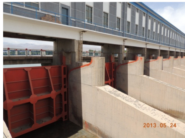
照片 12：草灘莊水利樞紐工程照片之三
