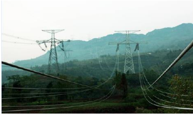
圖 14. DC UHV 系統輸配電線路
