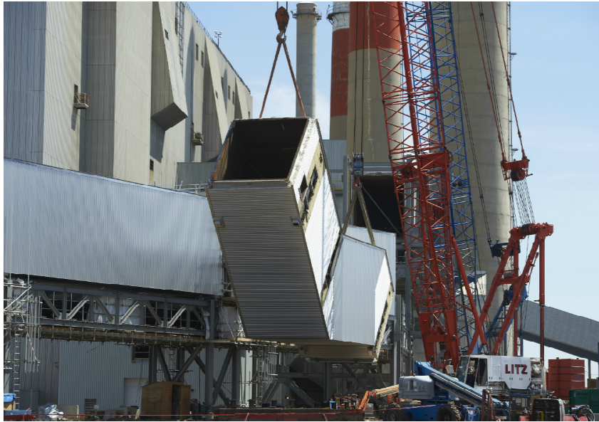
圖 2.2 Boundary Dam #3 現況
