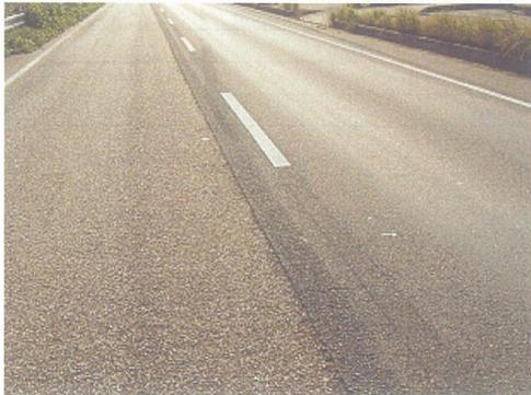
透水性舗装工区はわだち掘れなし。通常工区は 3cm 程度のわだち掘れ発生
