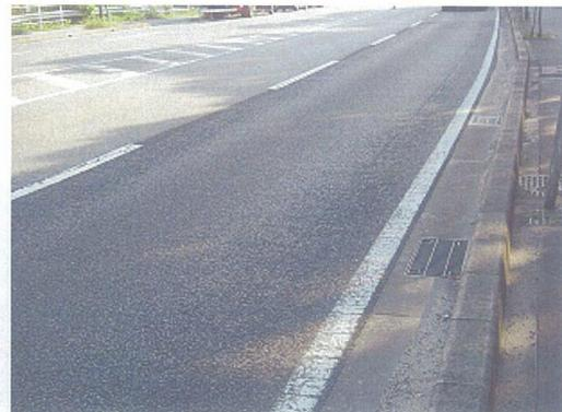
全体的に透水性による構造破損は見られない。
