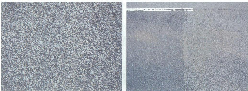
表層の一部で骨材飛散減少が見られる。
