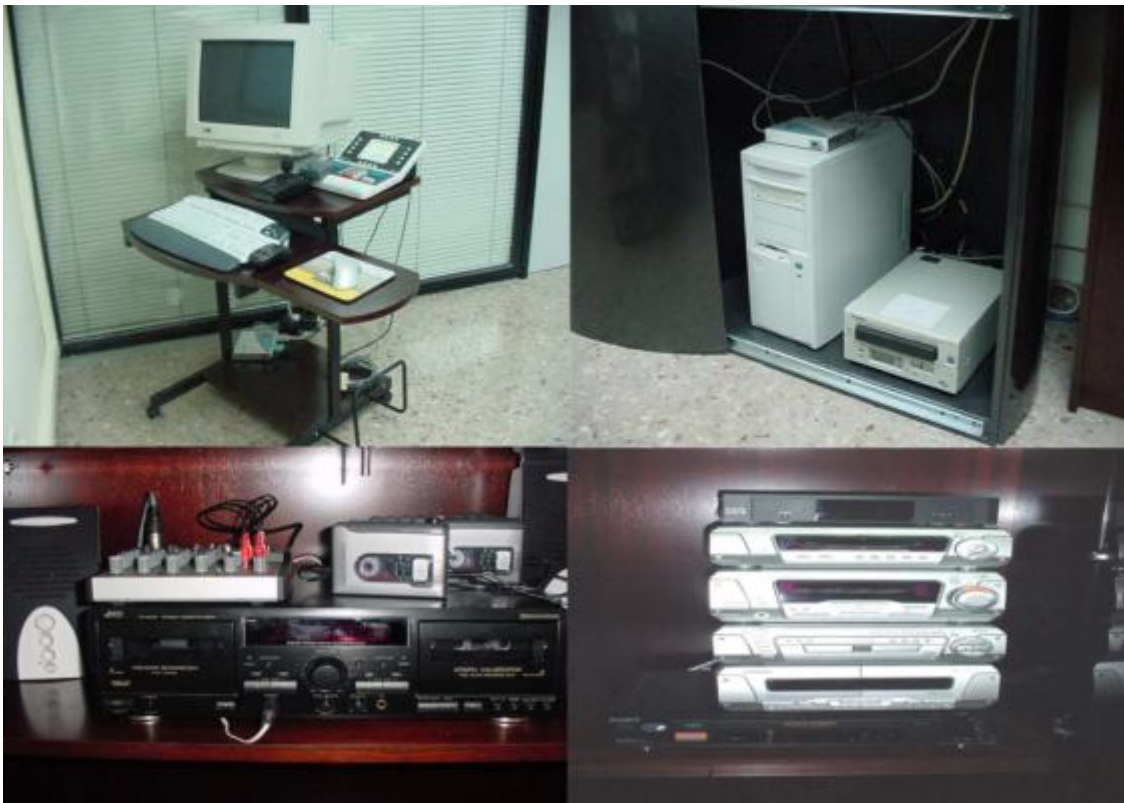
▲ 緊急營運中心內部空間與設備
