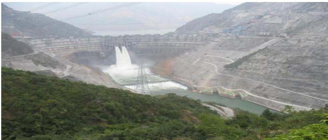
世界第一座300米级混凝土双曲拱坝电站-华能小湾，我国水电装机容量突破2亿千瓦大关标志
