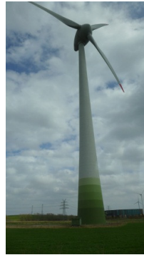
(f) Enercon 6MW 測 試中風力機
