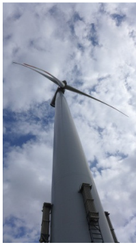
(e) GE 2.5MW 測試中 風力機
