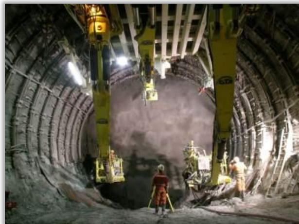
圖 4-15、瑞士 Gotthard Base 鐵路隧道鑽炸法區段懸吊式隧道開挖與支撐系統
