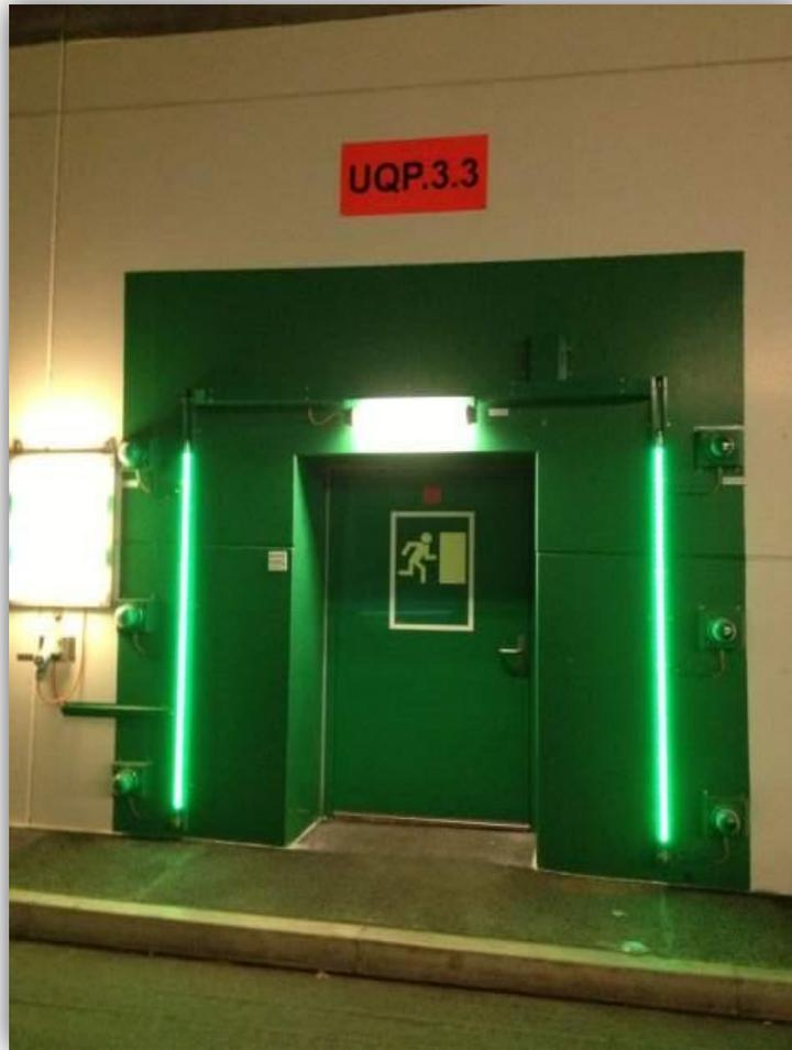
圖 4-2、Uetliberg Tunnel 逃生通道
