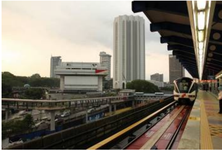
• LRT 是輕軌高架捷運
