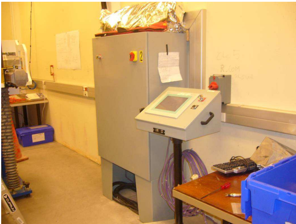
圖 10. 傾側旋轉測試檯控制面板及電器箱安裝
