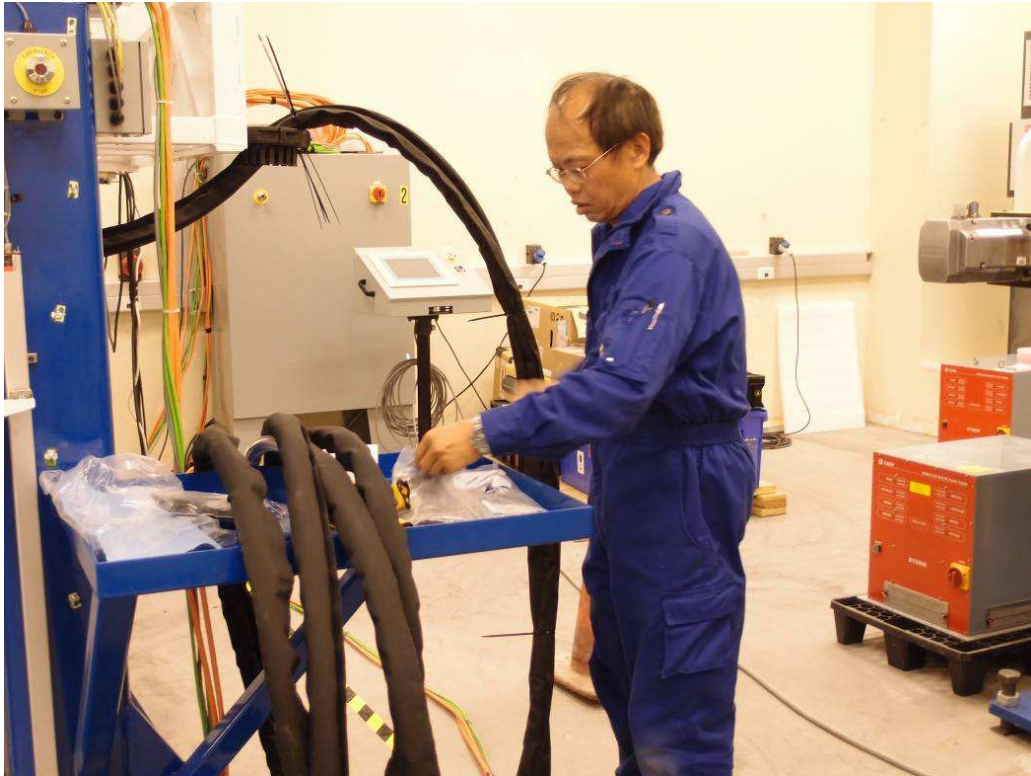
圖 15.冷凍系統壓縮機氨氣管施工
