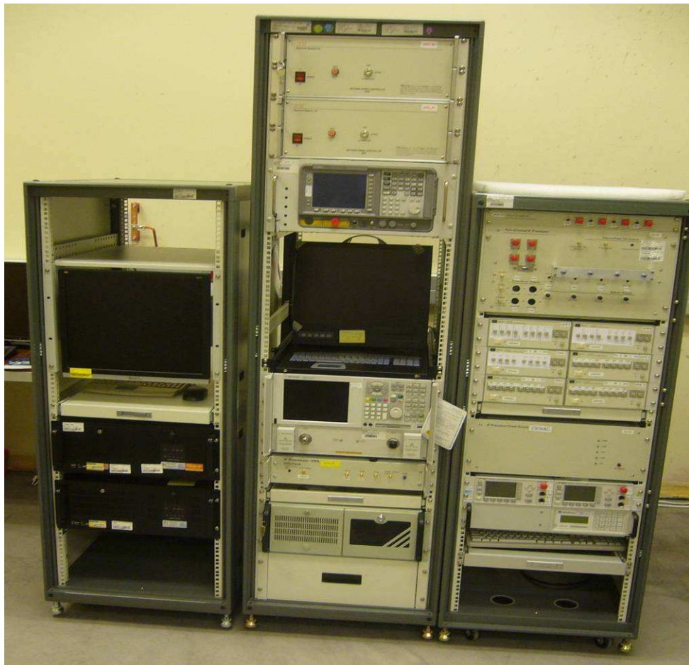
圖 7. 完成裝備開箱和機櫃組裝之量測系統
