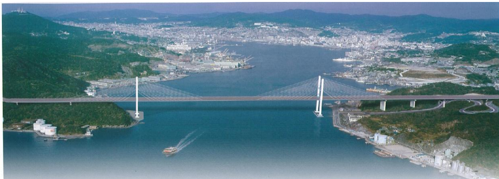
長崎港女神大橋
