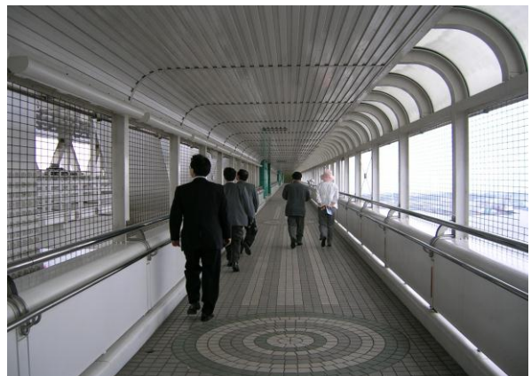
海灣大橋橋面人行步道
