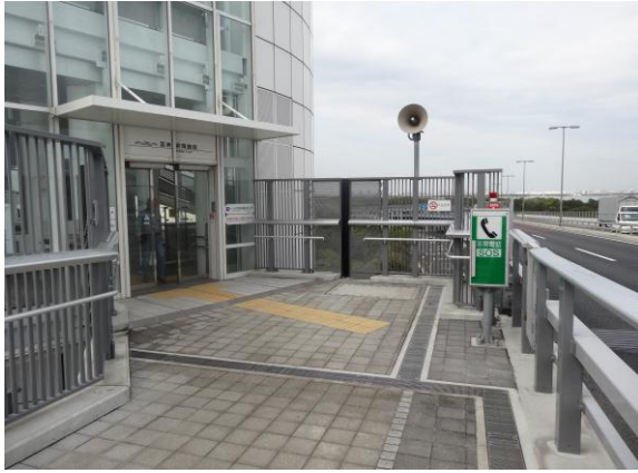
橋面電梯出口
