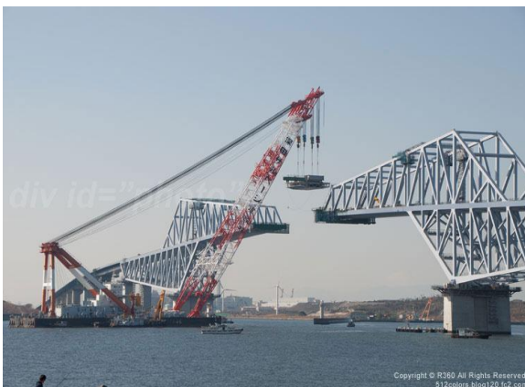
鋼桁架吊裝(資料)
