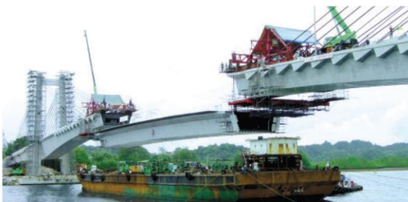
82m 鋼箱梁架設
