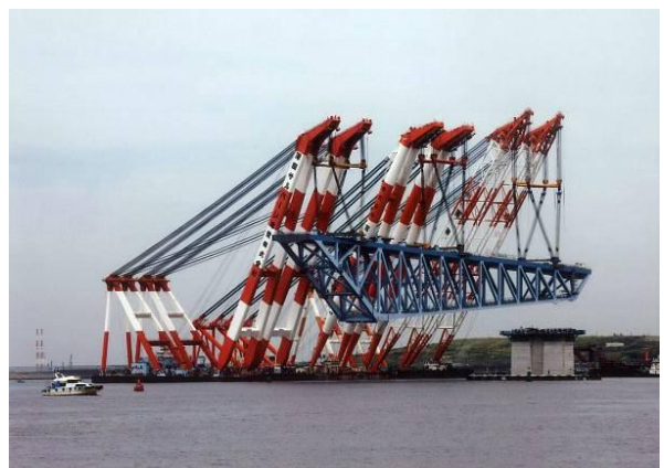
鋼桁架安裝於橋墩上(資料)
