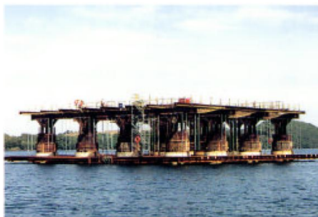
基礎施工吊支保工
