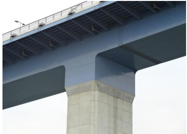
引橋剛接橋墩
