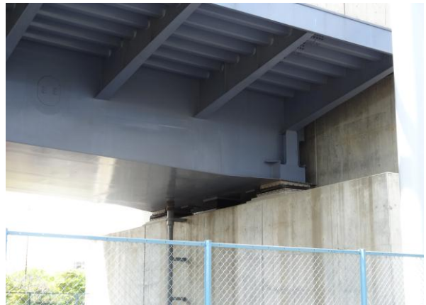
引橋橋台及排水
