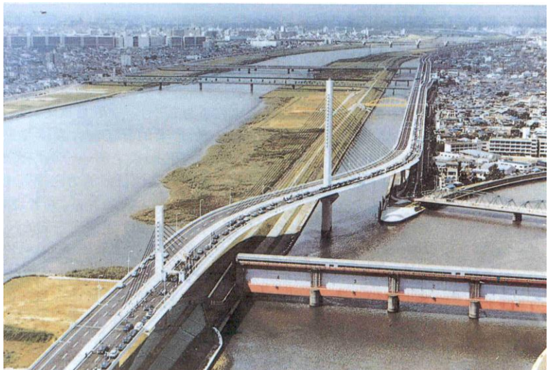
東京首都高速公路上的「葛飾橋」
