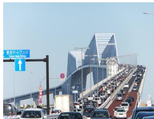
京門大橋主橋體前
