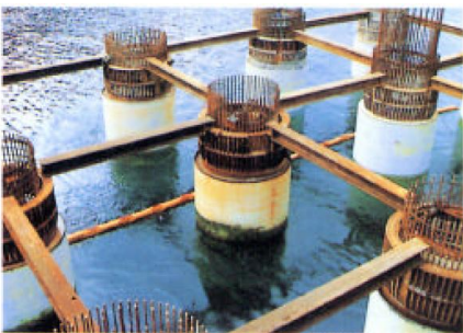
基礎施工桁架
