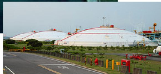
圖 12 JFE 公司製造之中油永安接收站地下儲氣槽
