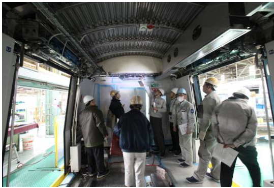
車頂電纜支撐架深度檢查
