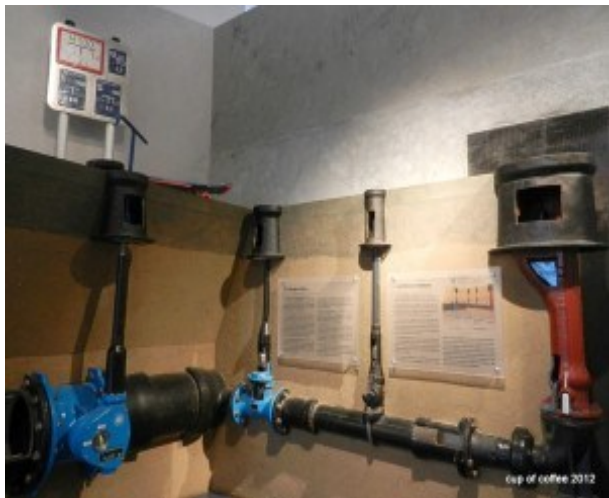
圖 39-16 漢堡水博物館- 現代漢堡供水管網及各種附屬設備(位置標籤、閥、閘閥、消防栓和服務連接的位置標記)在道路或人行道理設斷面情形
