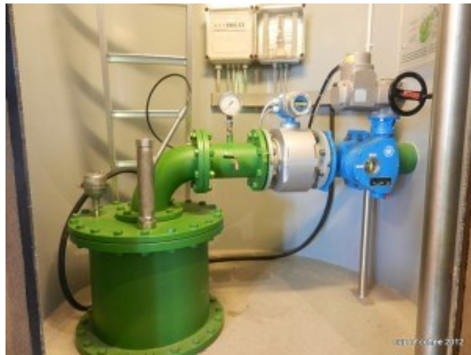
圖 39-12 漢堡水博物館- 現代水井抽水及監控設備
