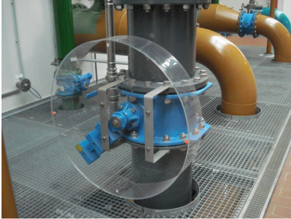
圖 38-7 漢堡水務中/東部(Mitte / Ost)淨水場管線顏色管理及操作安全保護設施
