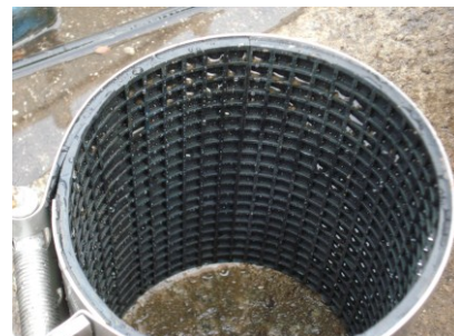
圖 32 漢堡水務人員示範從發現漏水至用管夾修漏之過程
