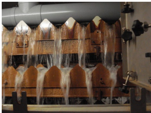
圖 38-4 漢堡水務中/東部(Mitte / Ost)淨水場新式(左)及舊式(右)曝氣設備
