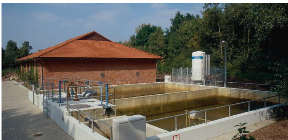
圖 38-5 漢堡水務中/東部(Mitte / Ost)淨水場廢水回收設備(供廠區植物及附近農作用)
