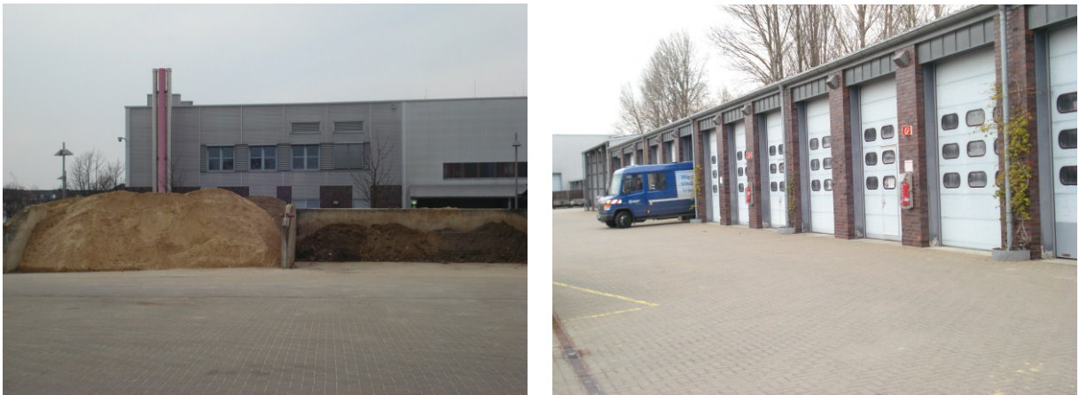
圖 34-1 漢堡水務供水設備維修中心-管溝回填料暫存區及各式任務車庫
