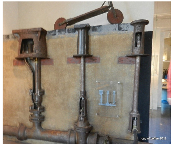
圖 39-16 漢堡水博物館- 現代漢堡供水管網及各種附屬設備(位置標籤、閥、閘閥、消防栓和服務連接的位置標記)在道路或人行道理設斷面情形
