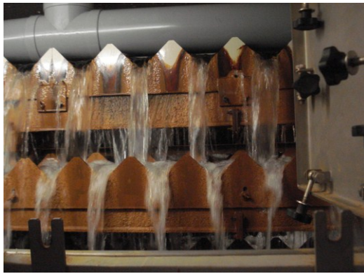
圖 38-10 漢堡水務中/東部(Mitte / Ost)淨水場新式(左)及舊式(右)曝氣設備
