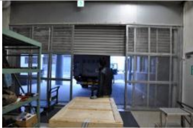
庫房鐵門及紗門
