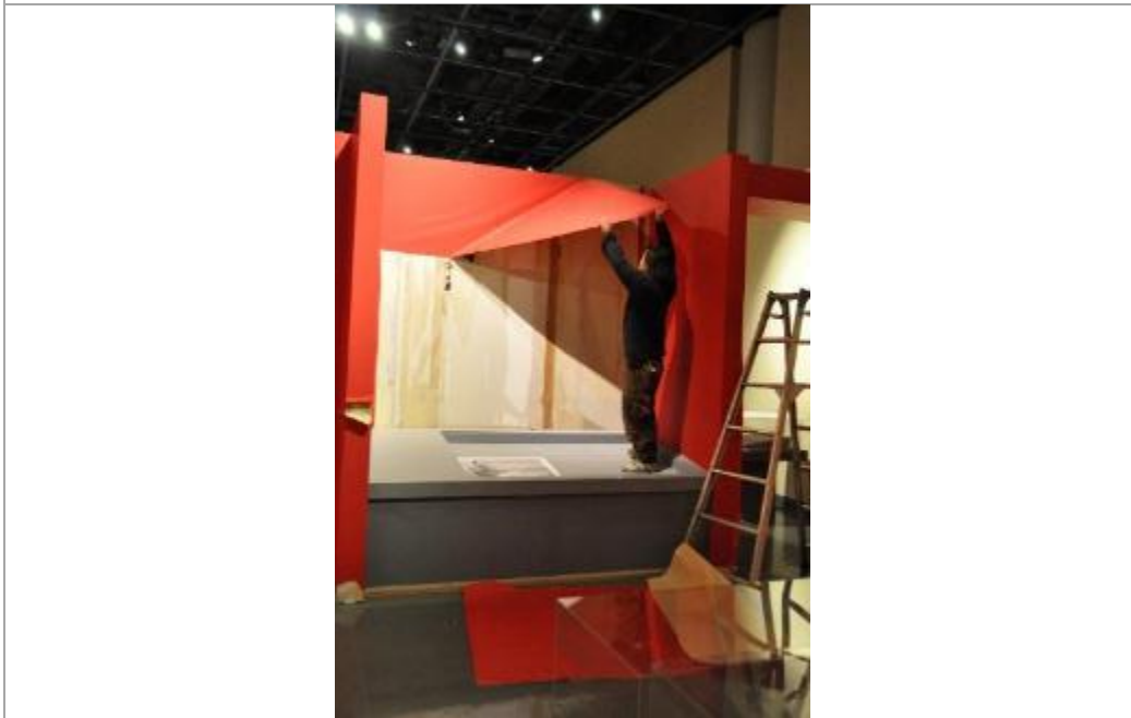
工作人員正進行展牆色紙拆除
