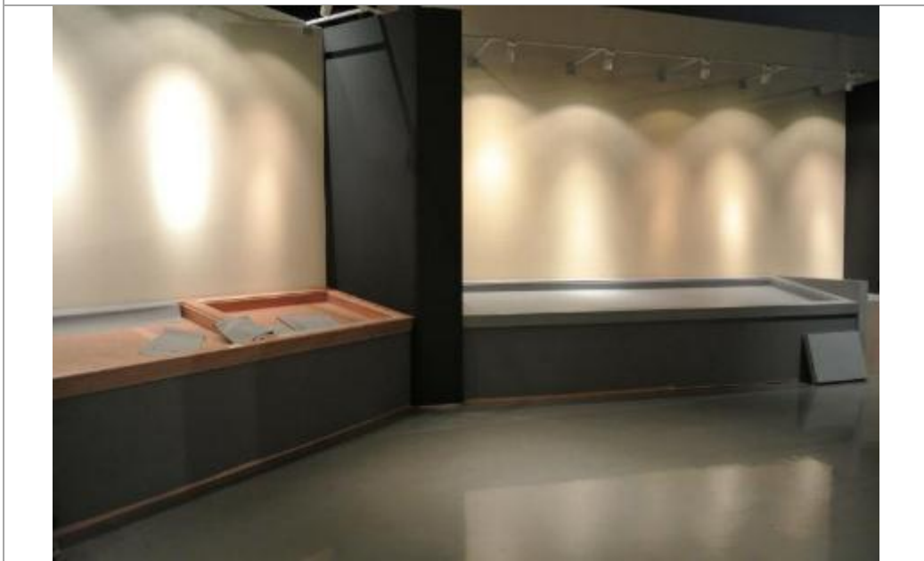
以壁紙整面性的包附夾板做上色與裝飾動作，圖片右邊展台已完成包覆灰色壁紙，左邊展台為施工中。
