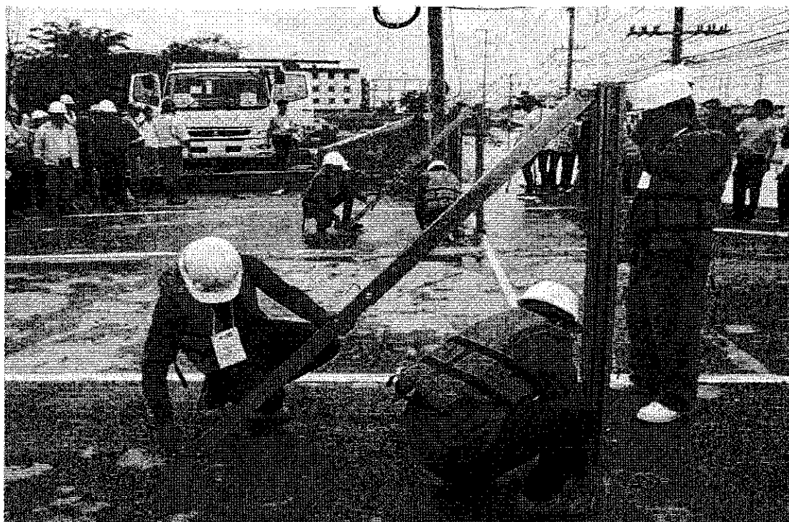
照片 18 Bang Pa-in 工業區出入口防洪牆閘板組裝演練（摘錄自簡報）
