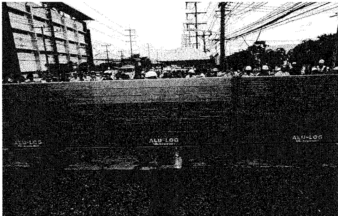
照片 20 Bang Pa-in 工業區出入口防洪牆閘板組裝演練（摘錄自簡報）
