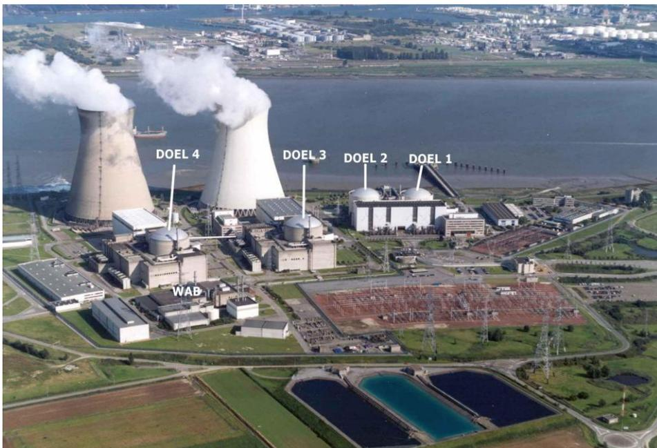
杜爾核能電廠目前正面臨2個巨大挑戰，第一個挑戰是2012年7月利用超音波檢測時，在三號機反應器壓力容器(reactor vessel)發現有缺陷(defect)。為了安全起見，杜爾電廠3號機暫停運轉，進行一連串的检查與測試，至今仍未起動運轉。第二個挑戰是，由於政治上的考量，Doel核能電廠一號機和二號機，決定2015年停止運轉，並進行除役。
