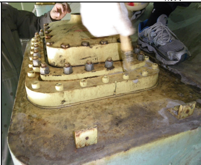
氫冷卻器洩漏檢測
