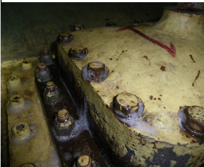
氫冷卻器洩漏檢測
