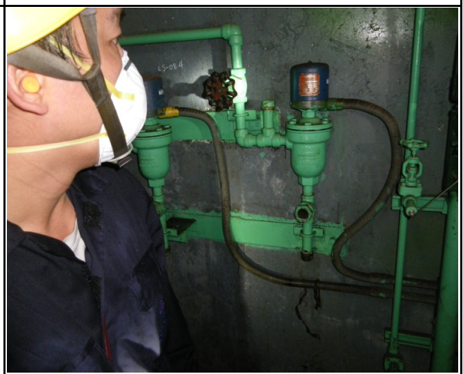
Gas Dryer洩漏檢測
