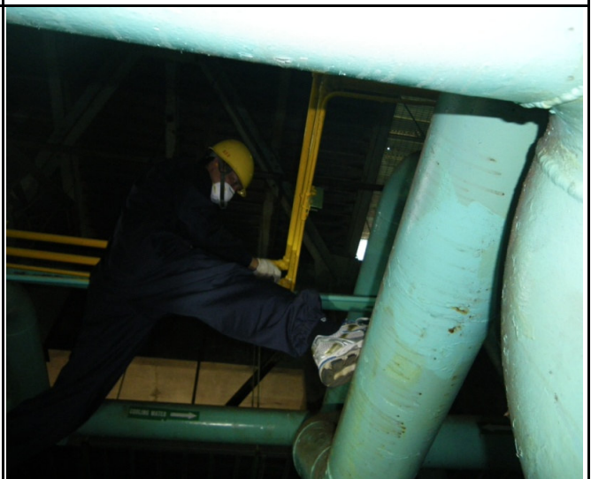
氫氣管路洩漏檢測
