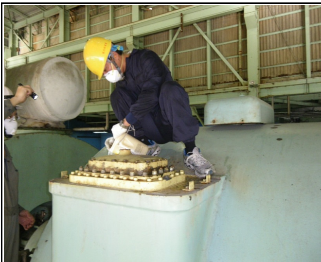
氫冷卻器洩漏檢測
