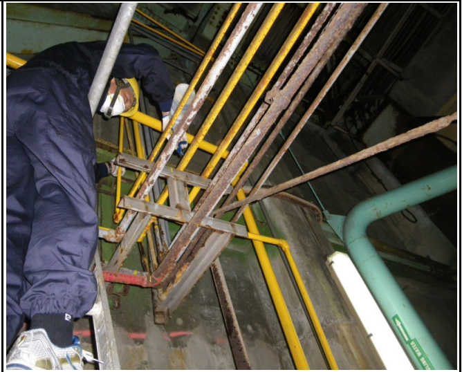
氫氣管路洩漏檢測
