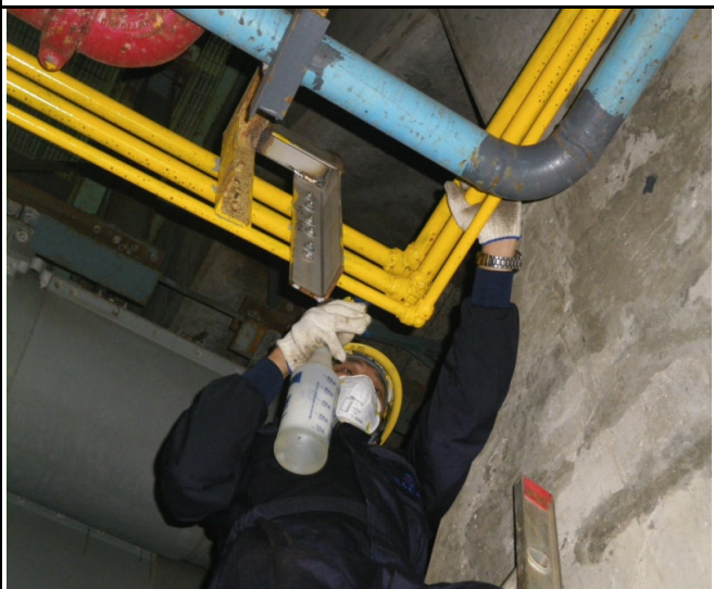
氫氣管路洩漏檢測
