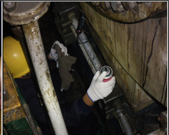
修補前清潔作業
