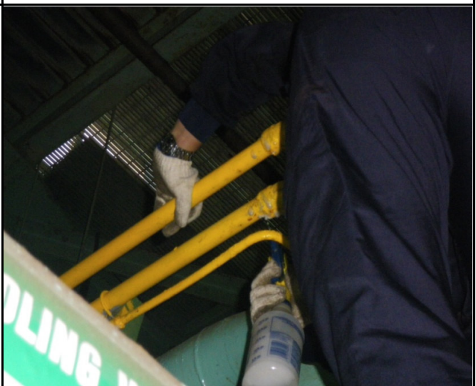
氫氣管路洩漏檢測
