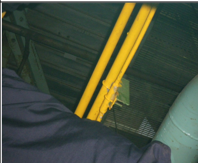
氫氣管路洩漏檢測
