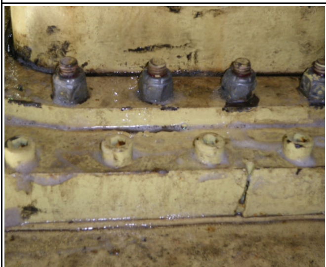
氫冷卻器洩漏檢測
