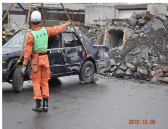
圖 44：於車輪前後用石塊固定
