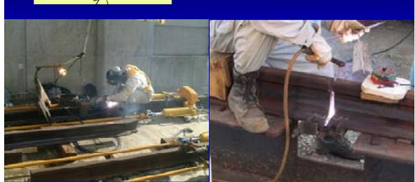
溶接後、緊張器を撤去し、付加緊張アンカー部の緩解、再締結を行い軸力の均一化を図る
