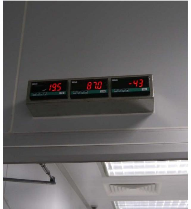
圖十一、溫、溼度及壓差監視系統
