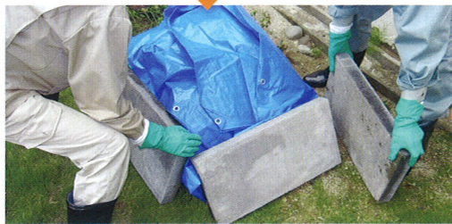
シートで養生後、コンクリートブロックで囲みます
