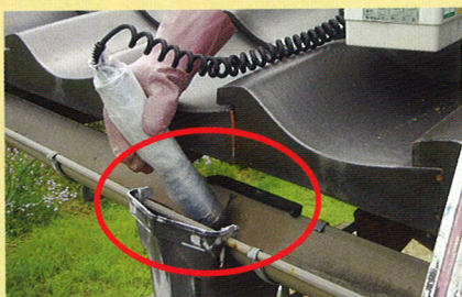
雨樋の集水器
