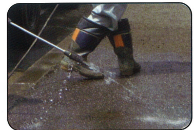
高圧水洗浄では、最初は通常の水压で排水溝までの水の流れを確認。
