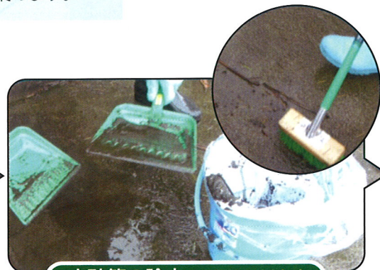
土砂等の除去（外側から内側へ）
