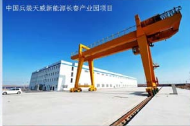
中国兵装天成新能源长春产业园项目
