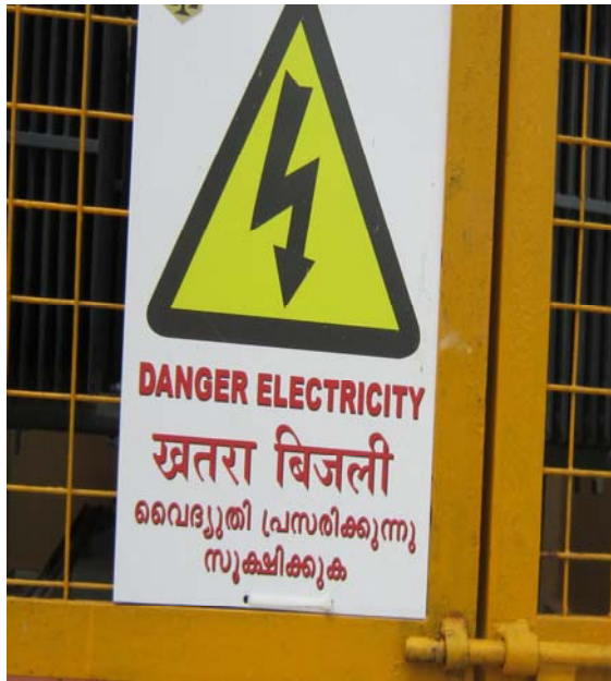
1. 高壓電氣危害標示
