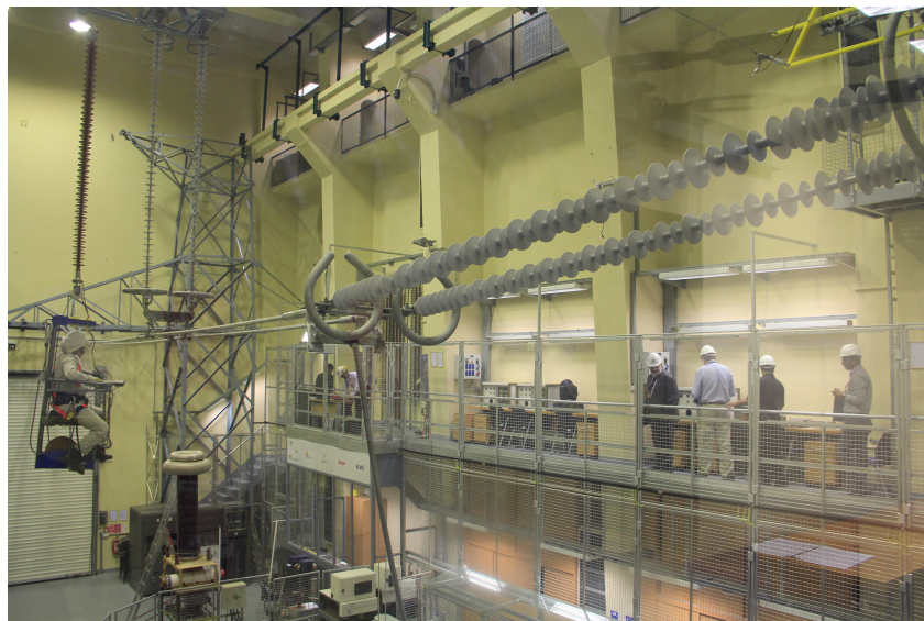
超高壓活線作業等電位放電展演
