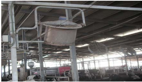
牛舍降溫設施之大型旋轉風扇並具噴水裝置之噴頭
