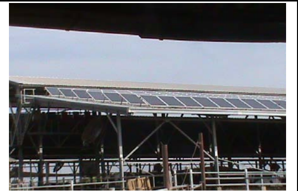
移動式牛舍屋頂通風且接受陽光晒乾牛床，屋頂且均安裝太陽能板
