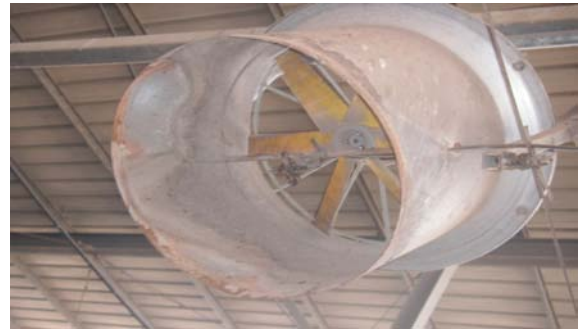
牛舍降溫設施之大型旋轉風扇並具噴水裝置之噴頭
