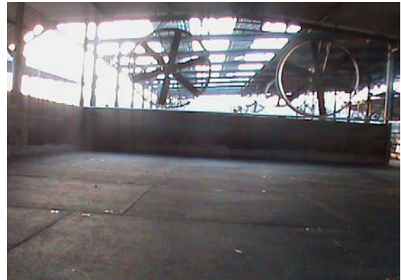
寬敞之擠乳間等待區設置淋浴及大型風扇裝置來舒解熱緊迫
