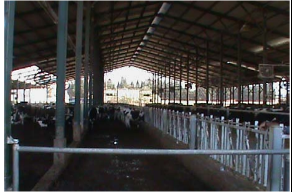
人字形屋頂挑高且寬有設置中央餵飼走道
