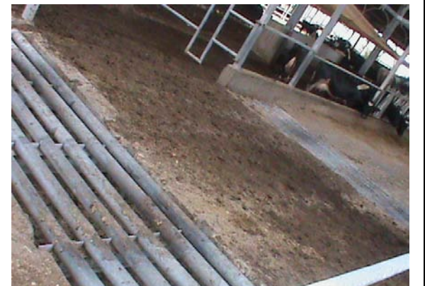
牛舍無鐵門規劃走道以鐵管溝蓋設置
