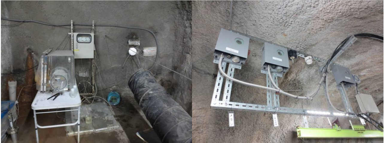
圖 17 幌延地下實驗室地下 140 m 主要實驗(1)
