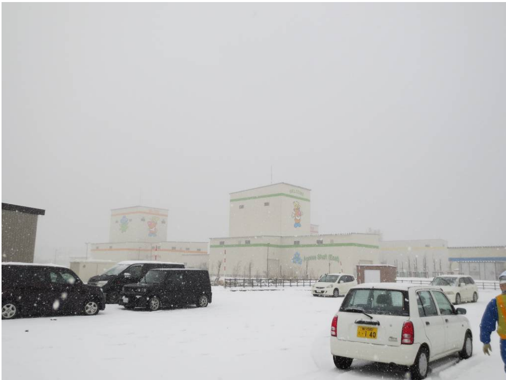
圖 15 幌延地下研究中心的東立坑(右，綠色)和西立坑(左，橘色)
