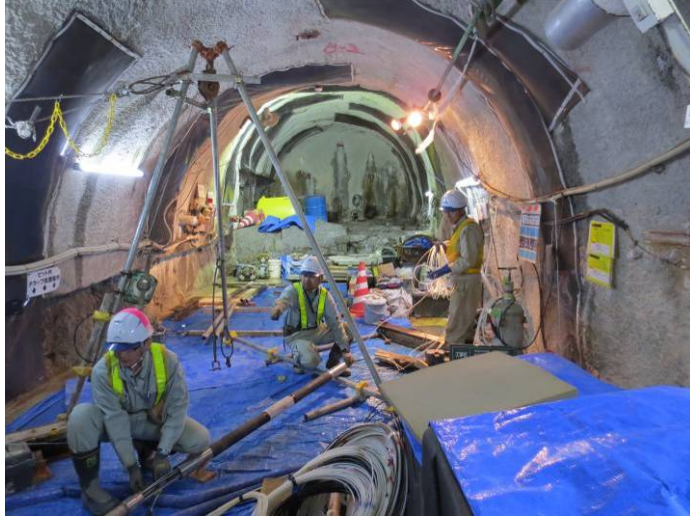
(b)水文試驗孔內安裝壓力計
