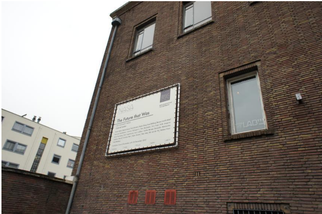
荷蘭 Smart Project Space 外觀，原本是解剖病理學實驗室
