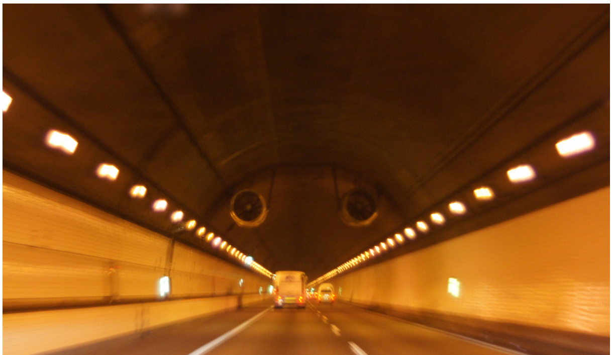
圖 4-2.8 橫斷道路隧道內增壓風機
