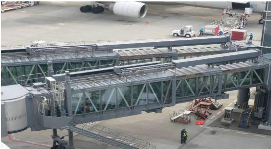
圖5-4 羽田機場 空橋 (機械螺桿式升降柱+玻璃外牆)
