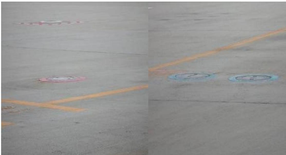
圖5-6 機坪設置地下埋管式油管、400Hz電源及PC-AIR冷氣風管設施 (關西機場實景)
