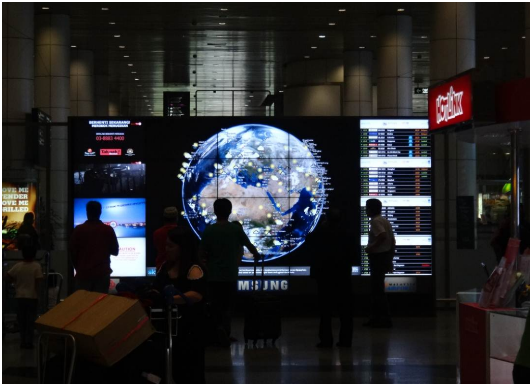
圖 12. 主航廈報到大廳 FIDS 電視牆搭配 GOOGLE EARTH 顯示班機動態資訊
