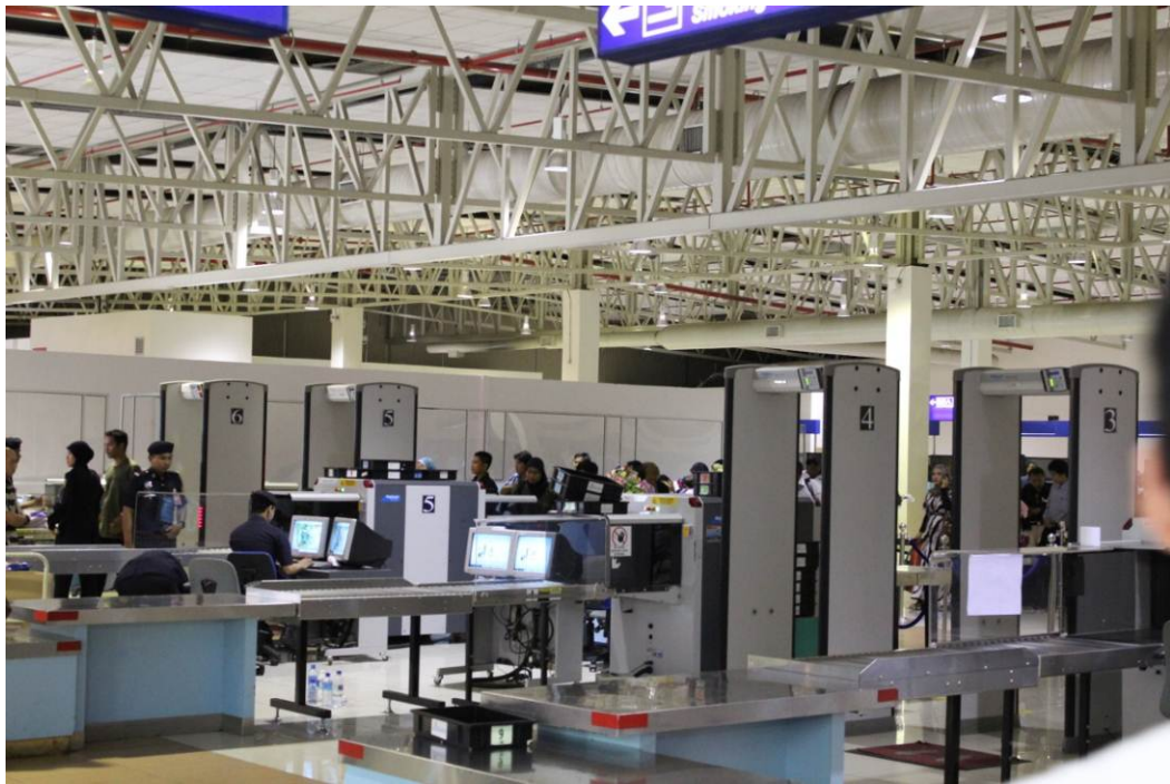
圖 18. LCCT 航廈安檢區的天花板設計
