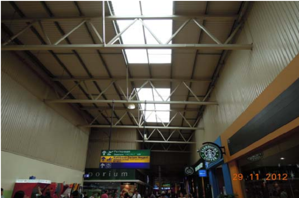
圖 20. LCCT 管制區外天花板設置：商店街自然採光且無空調
