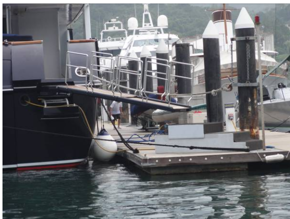
浮動碼頭乾舷甚低，大型遊艇尚需利用階梯才可以上下船
