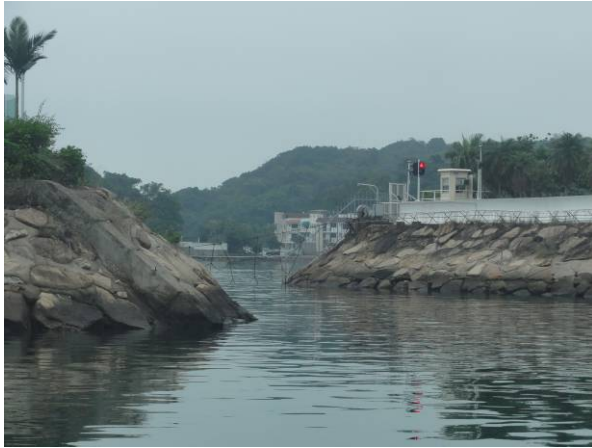
泊區出入口設有管制站控制鐵鍊柵欄，管制船舶之進出
