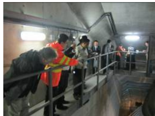
參觀青馬大橋內部
