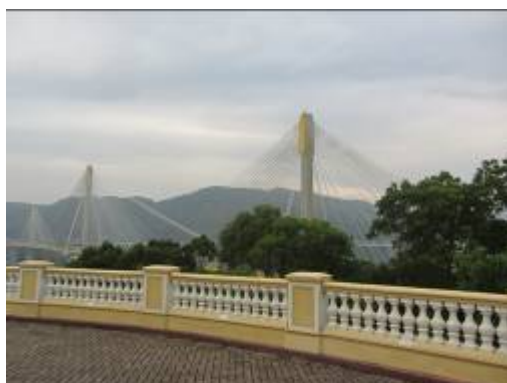
香港汲水門大橋
