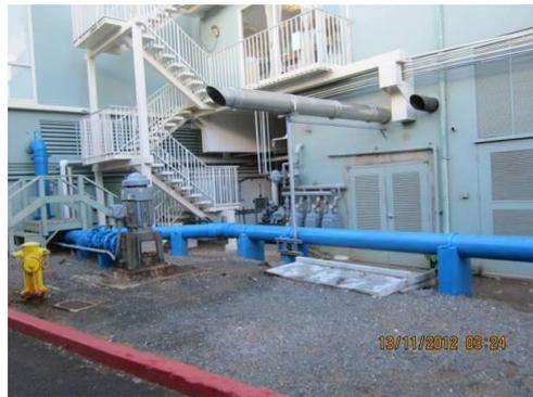
圖 53 以地下水作為冷卻水的空調冷卻系統
