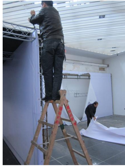
右圖 6：工作人員協助拆除桁架
