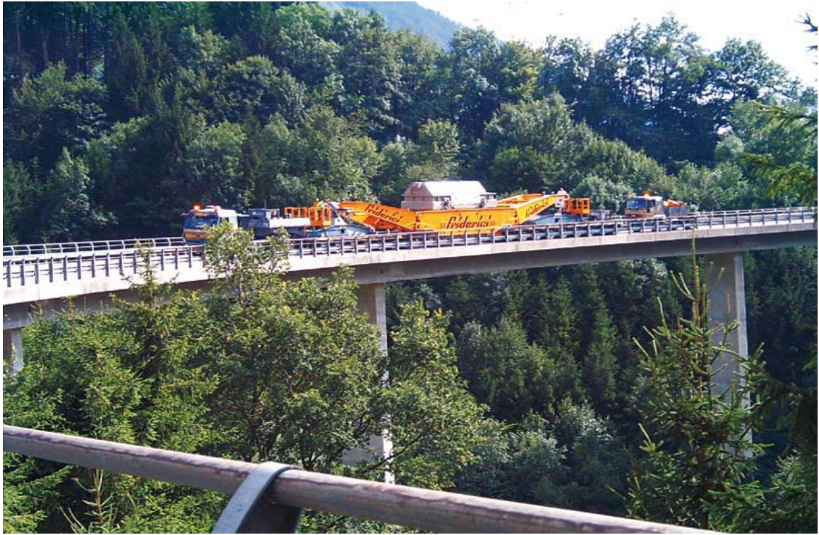
圖 24 以道路運方式運送變壓器
